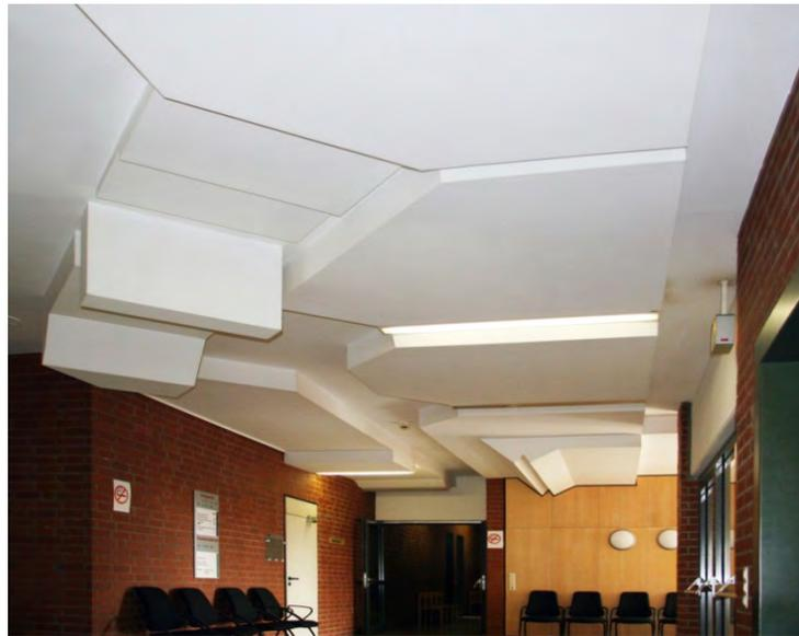
**Abb. 145: Deckenrelief mit integrierter Beleuchtung**
