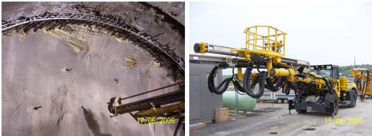
**Abb. 1.7: Herstellung der Spieße (links); Bohrwagen (rechts) [28]**
