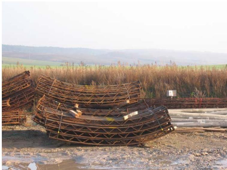
**Abb. 1.5: Gitterträger auf der Tunnelbaustelle (2007-01-07)**
