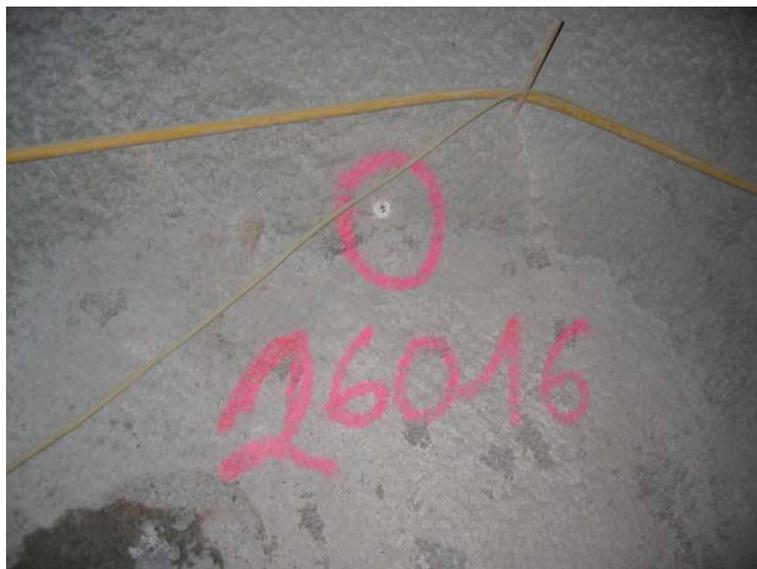
**Abb. 4.4: Festpunkt des Vortriebsnetzes im Schmücketunnel**
