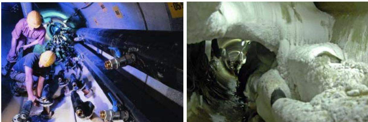
**Abb. 3.7: Gefrierrohre im Pilotstollen – während der Montage (links) und im Betrieb (rechts) [8]**
