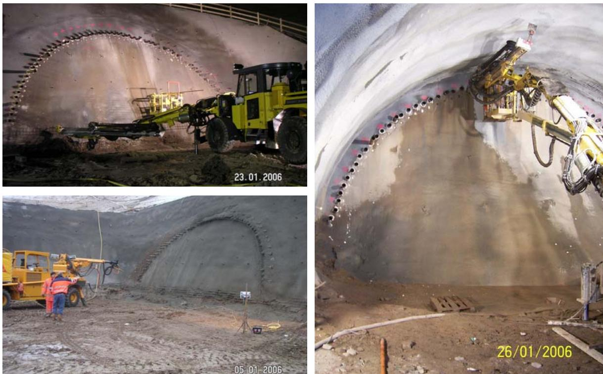
**Abb. 1.8: Herstellen des Rohrschirmes am Vortrieb Nordost – Schmücketunnel [28]**
