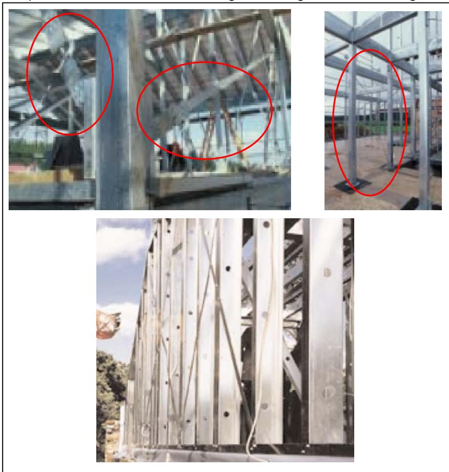
Abbildung 4.65: Beispiele zur Ausbildung von Wandverbänden, aus [Z2]
