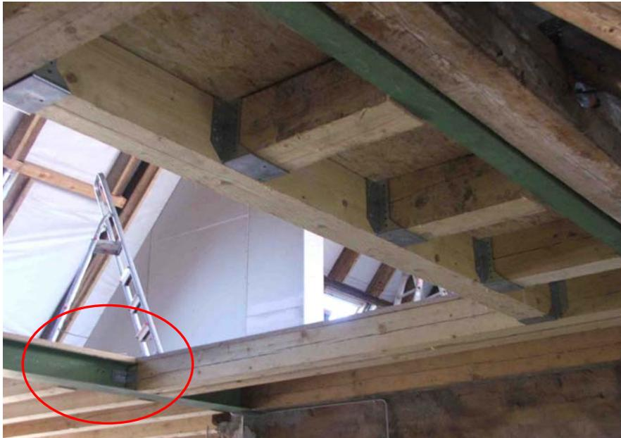
Abbildung 4.44: Ersatz der Wände durch Stahlunterzüge, aus [Q1]
