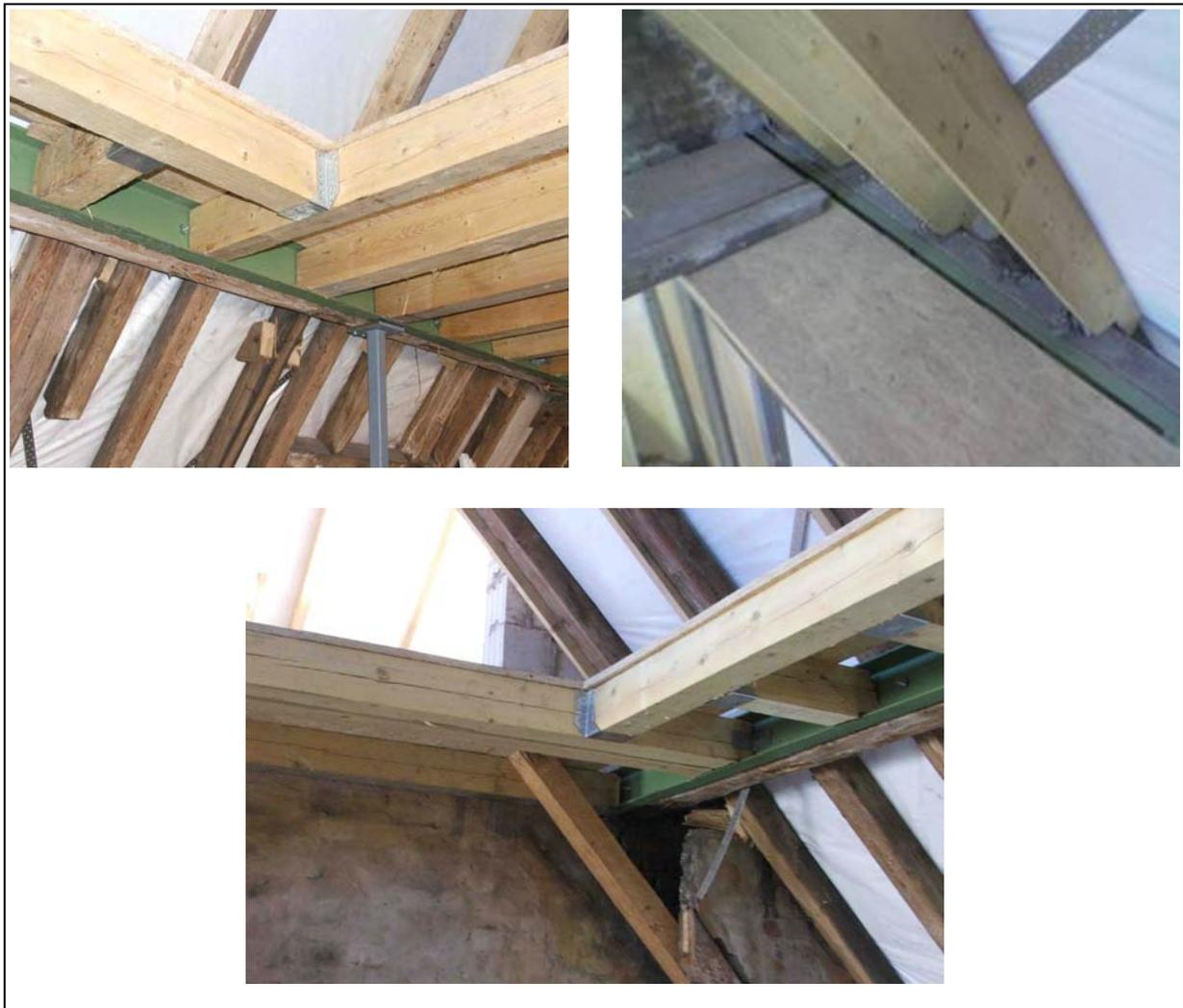
Abbildung 4.68: Verstärkung der Mittelpfette durch U-Profile, aus [Q1]
