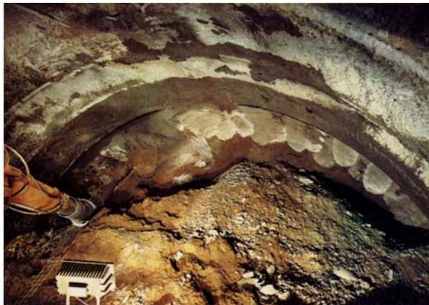
**Abb. 3-3 Abfräsen mittels Teilschnittmaschine [5]**
