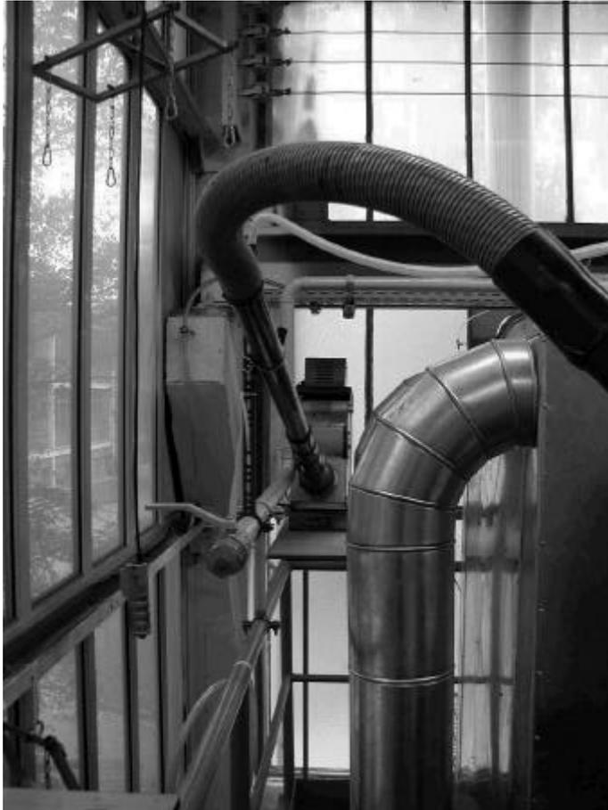
Abb. 28 Fischbach-Lüfter mit Sekundärluftleitung
