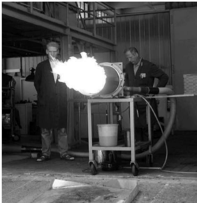
Abb. 21 Verbrennungsversuche im offenen Verbrennungsrohr mit DK
