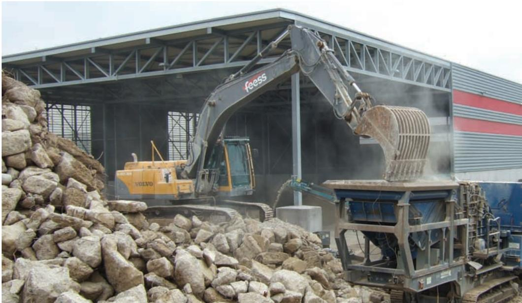
selektiven Rückbau der Altgebäude kann die erforderliche Qualität erreicht werden. Die Aufbereitungstechnologie von RC-Gesteinskörnungen ist für eine Verwendung in der Betonherstellung oder im Straßenbau identisch. Die Qualität der Gesteinskörnungen richtet sich nach den technischen Baubestimmungen und ist durch Übereinstimmungszertifikate nachzuweisen.
