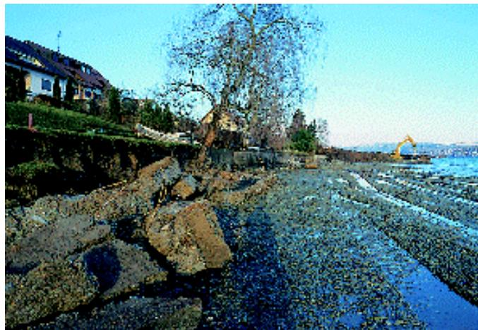
**Wie die Verbauung selbst, ist auch die Renaturierung der Bodenseeufer mit beträchtlichem technischen Aufwand verbunden; hier wird eine Ufermauer abgebaut und das Gelände anschließend mit Kies der Böschung angeglichen.**
