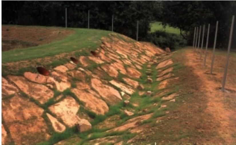
Abbildung 17: Entlastungsbauwerk (verdeckte Entlastungsrohre) mit Ableitungsgraben (Mischsystem).
