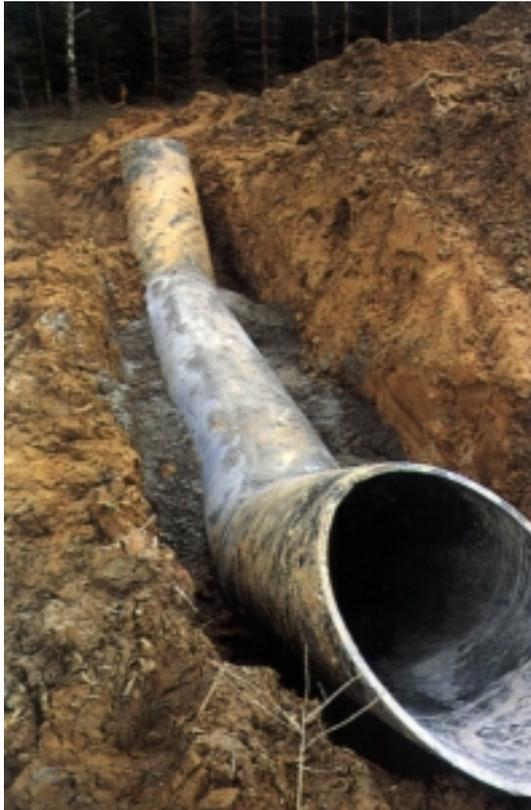
Abbildung 19: Verdeckte, vorgefertigte Entlastungsrohre beim Einbau (Trennsystem).
