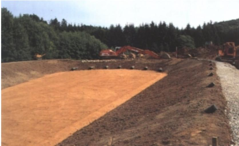
Abbildung 3: Retentionsfilteranlage nach Abschluß der Erdarbeiten.
