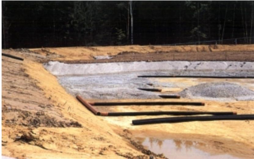
Abbildung 1: Retentionsfilteranlage mit natürlicher Basisdichtung, im Bau.
