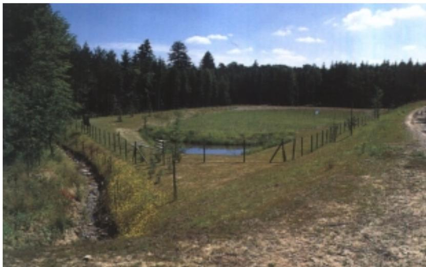
Abbildung 14: Retentionsfilteranlage vor Inbetriebnahme (Trennsystem).
