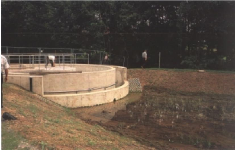
Abbildung 7: Breitflächiges Zulaufbauwerk. Filteranlage noch nicht in Betrieb (Mischsystem).
