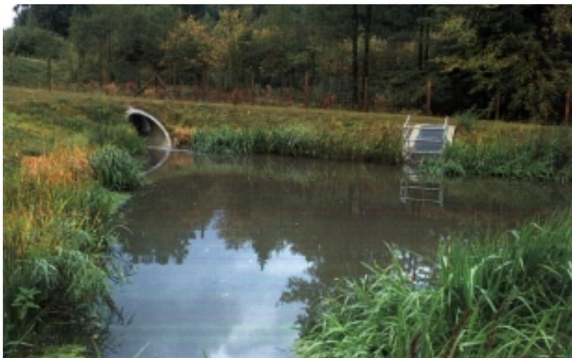
Abbildung 12: Regenwasserteich als 1. Stufe einer Retentionsfilteranlage (Trennsystem).
