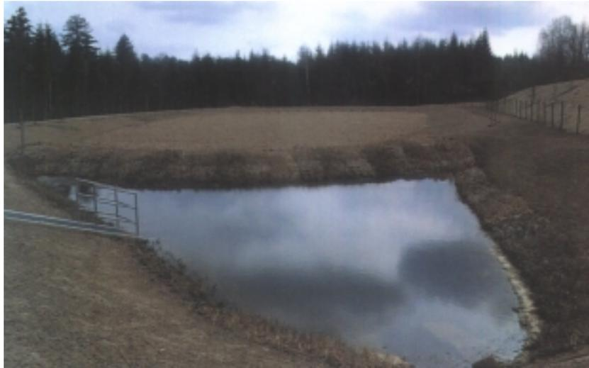
Abbildung 13: Retentionsfilteranlage nach Abschluss der Bauarbeiten (Trennsystem).
