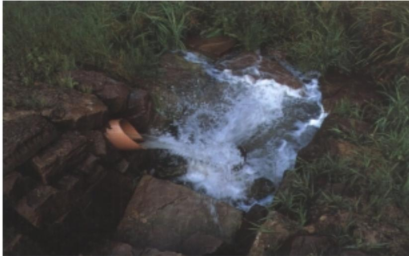
Abbildung 21: Ein lebendiger Quell. Ablauf der Drainage einer Retentionsfilteranlage (Trennsystem).
