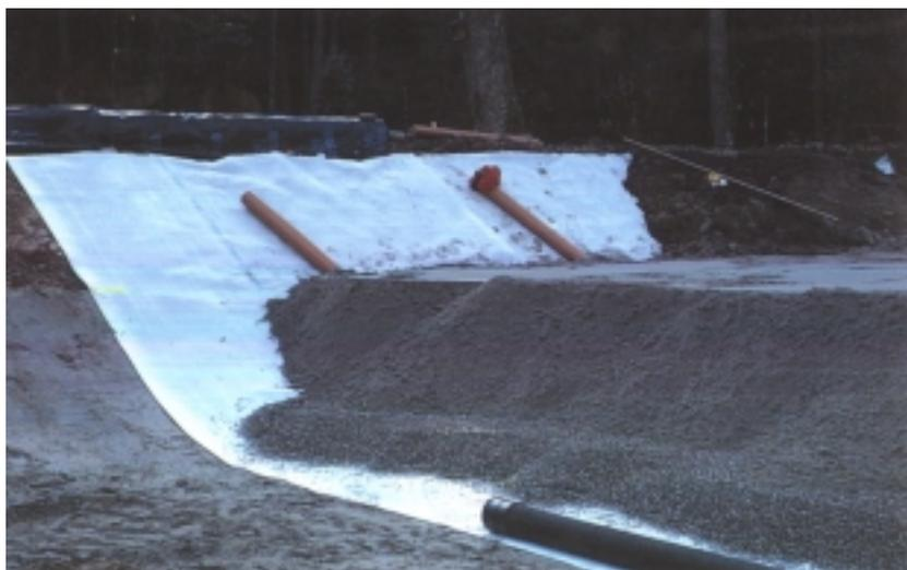
Abbildung 2: Retentionsfilteranlage mit künstlicher Basisdichtung (Bentonitmatten), im Bau.
