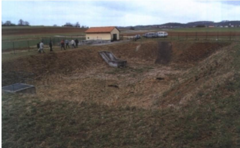
Abbildung 9: Mechanischer Filter mit Grasbewuchs (Mischsystem).
