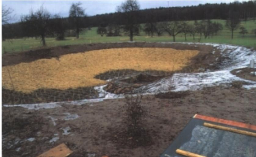
Abbildung 5: Punktförmiges Zulaufbauwerk mit Gabionen. Filteranlage noch nicht in Betrieb. Der Lehm Boden wird gerade mit Mulch abgedeckt (Mischsystem).
