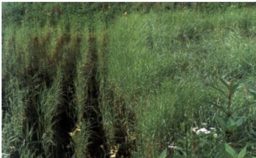
Abbildung 10: Retentionsbodenfilteranlage mit Schilfbepflanzung im Anwachsstadium. Schilfmatten (rechte Bildhälfte) und Setzlingen, 4St/m<sup>2</sup> (linke Bildhälfte) (Mischsystem).
