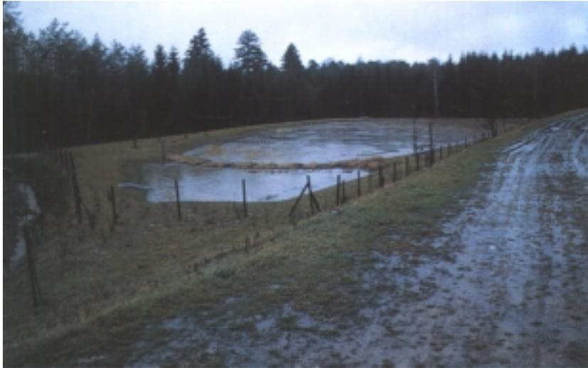
Abbildung 15: Retentionsfilteranlage in Betrieb (Trennsystem).
