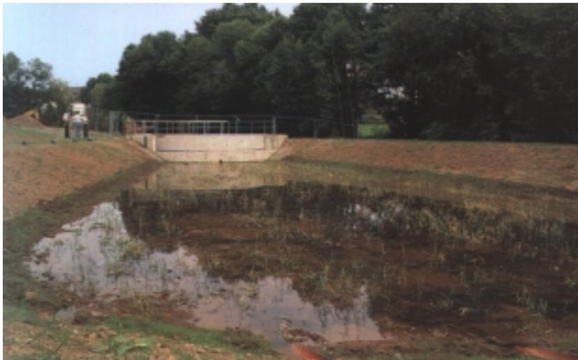
Abbildung 8: Retentionsfilteranlage in Tropfenform. Der Filter ist zur Förderung des Schilfwachstums zeitweise überstaut (Mischsystem).
