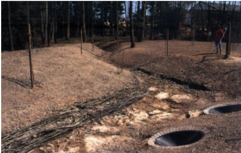
Abbildung 16: Entlastungsbauwerk (verdeckte Entlastungsrohre) mit Ableitungsgraben (Trennsystem).
