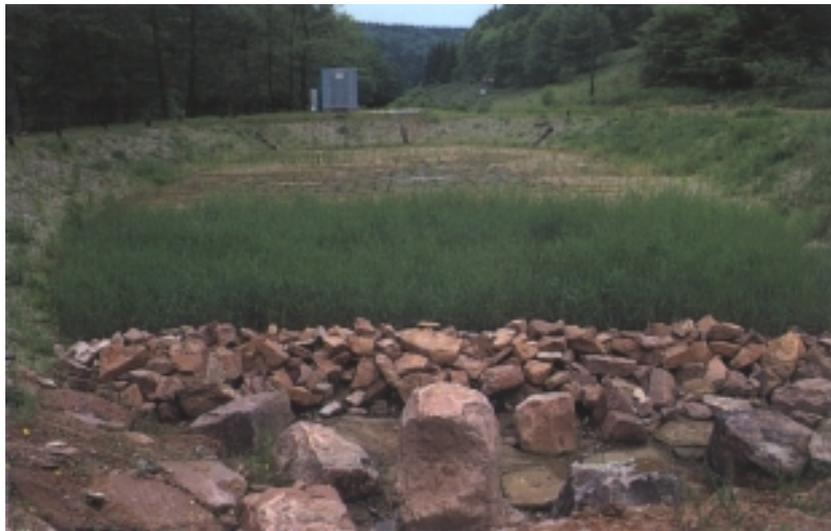
Abbildung 6: Punktförmiges Zulaufbauwerk mit Steinschüttung und Energieumwandlung. Filteranlage noch nicht in Betrieb (Mischsystem).
