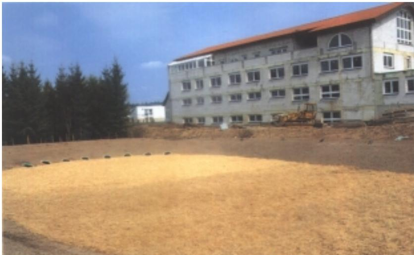
Abbildung 4: Retentionsfilteranlage. Der Lehm Boden ist zum Schutz vor Verschlämmung mit Mulch abgedeckt (Trennsystem).
