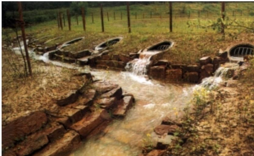
Abbildung 18: Entlastungsbauwerk (verdeckte Entlastungsrohre) in Betrieb (Trennsystem).
