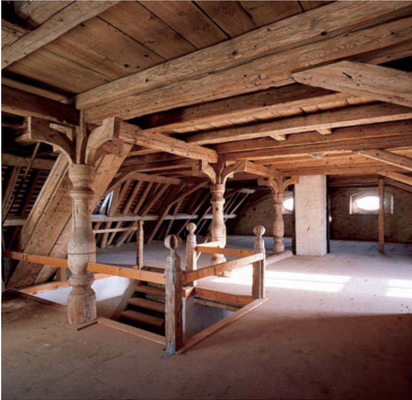
13 Pfarrhaus Otterswang: Der mit seinen gedrehten Säulen und knieförmigen Kopfstreben besonders aufwändig gestaltete Dachstuhl, beschickt über die Luken der zweigeschossigen Gaube, diente zur Lagerung des herrschaftlichen Zehnten.
