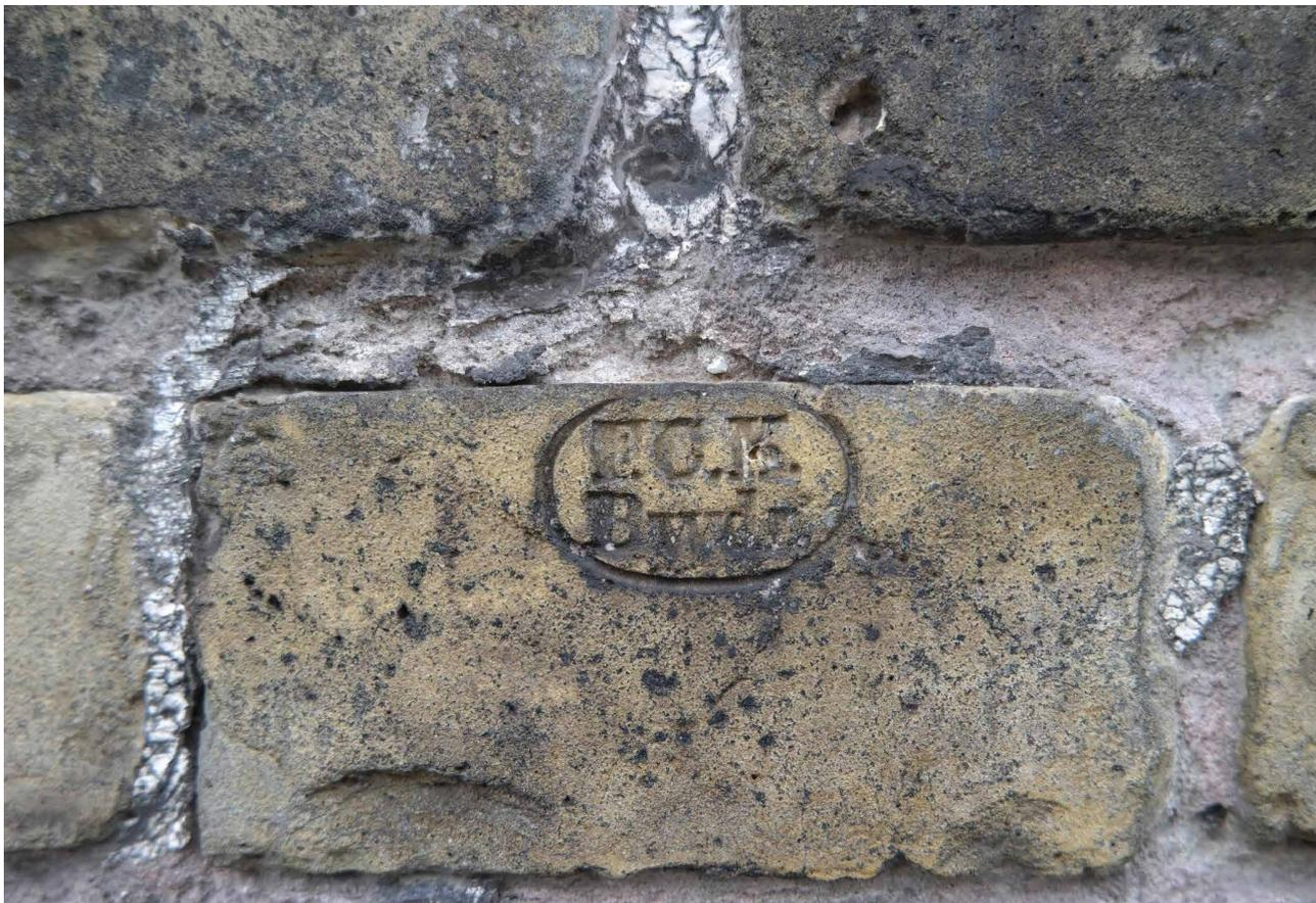
Abb. 13: Bauzeitliches kasernenzeitliches Sichtmauerwerk mit Ziegelstempel, BSQB/SDARC
