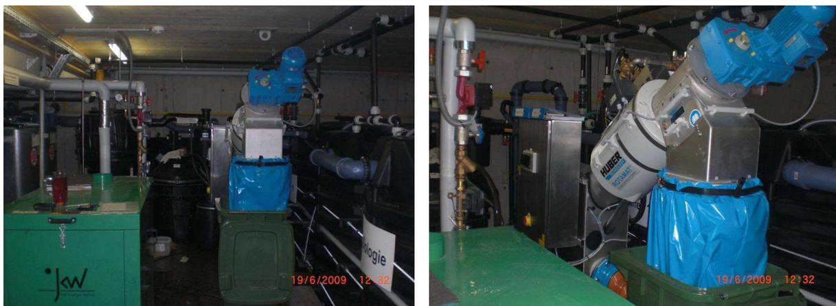
Abbildung 11: Nachgerüstete, mechanische Vorreinigung (HUBER Ro9)
