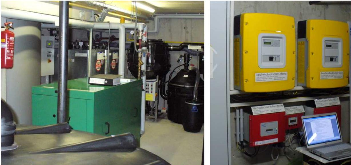
**Abbildung 4:** Links: Blick auf das BHKW mit Pufferspeicher, Rapsöltanks im Hintergrund ; rechts: Inselwechselrichter (oben) und PV-Wechselrichter mit Datenpuffer (unten)
