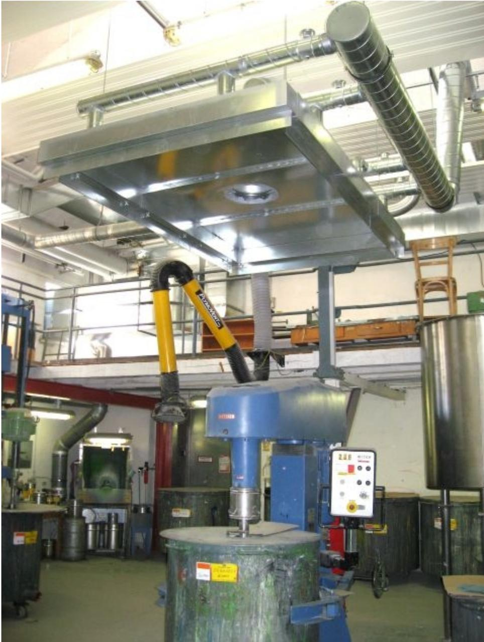
Bild 6: Fangplatte mit Schlitzdüse für Luftschleier. Der umlaufende Luftschleier kesselt die austretenden Emissionen ein. Die Absaugung erfolgt in der Mitte der Fangplatte.
