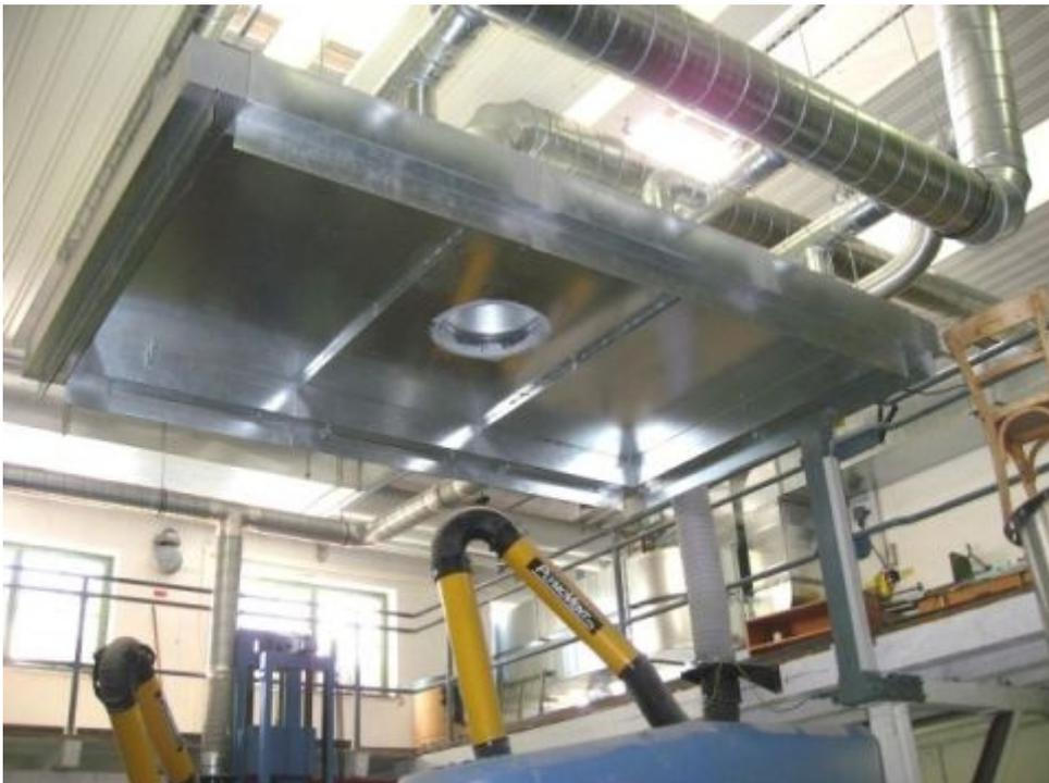
Bild 18: Fangplatte mit Luftschleierdüse
