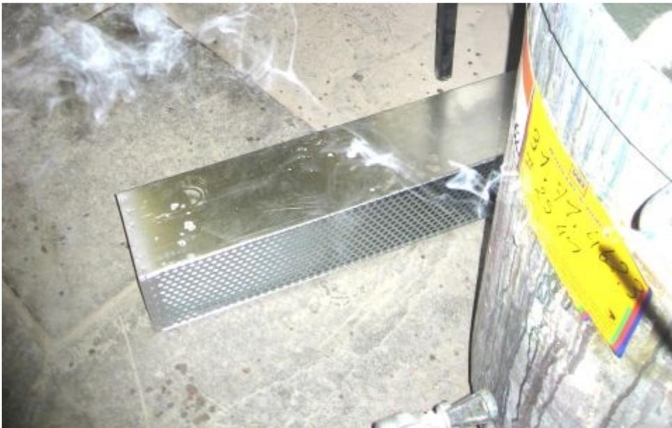
Bild 14: Absaugung und diffuse Luftverteilung
