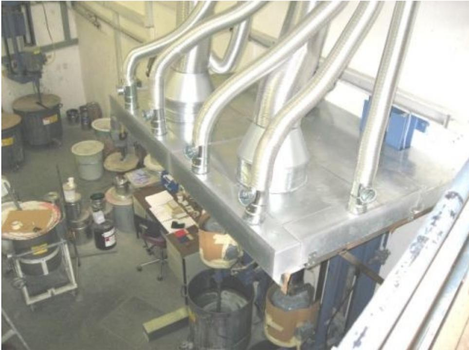
Bild 8: Für ein gleichmäßiges Strömungsprofil der Luftschleier wurden individuell einstellbare Zuluftführungen installiert.
