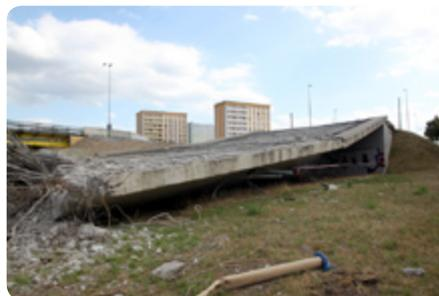
*Die alte Brücke über die Schnellstraße ist fast abgerissen. Nach der einwöchigen Vollsperrung demontierte die Firma Streicher die Pfeiler bei laufendem Verkehr. Die Behelfsbrücke funktioniert gut und die Einschränkung der Spuren führte im Sommer kaum zu Beeinträchtigungen.*
