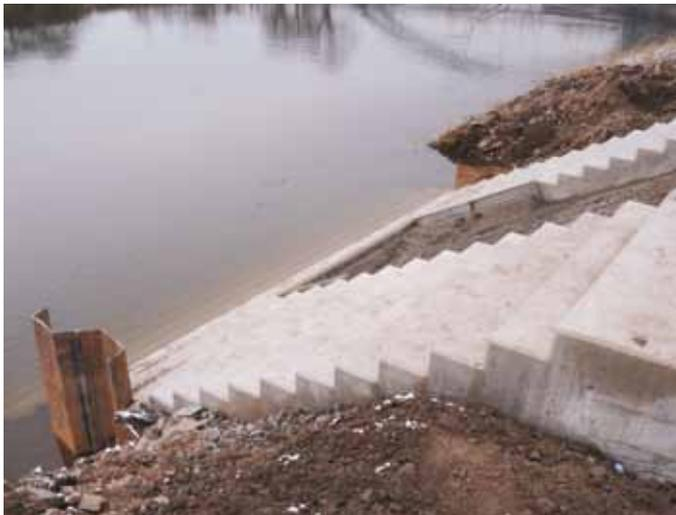
Bild 9: Bauausführung – Betonage abgeschlossen
