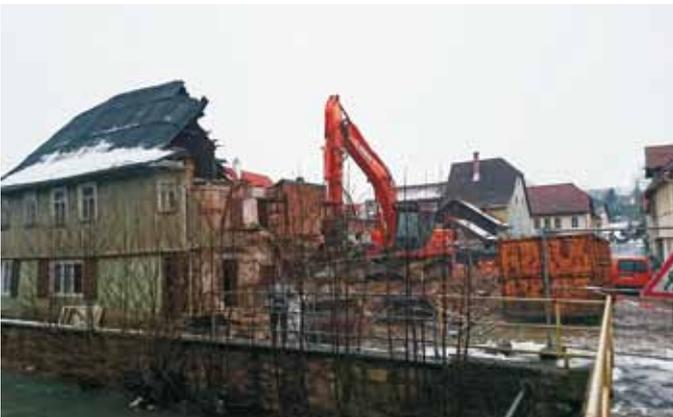
Bild 17: Rückbau eines Wohngebäudes zur Baufeldfreimachung, (HSP)
