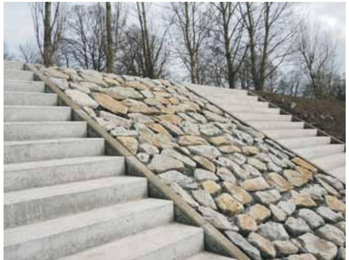
Bild 10: Bauausführung – Zwischenbereich zwischen Landzugängen befestigt
