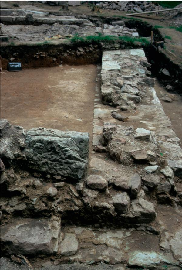
**Abb. 7** Suhl-Albrechts, Kapelle „St. Anne“; die Mauerbreite lag bei durchschnittlich 1,05 m sowie auf der Gründungssohle bei 1,30 m.
