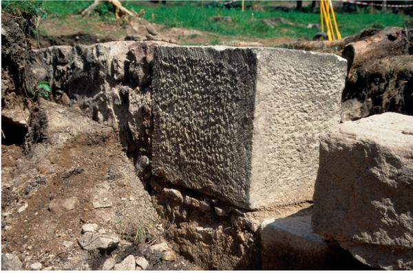
**Abb. 5** Suhl-Albrechts, Kapelle „St. Anne“, Schalenmauerwerk der Kirche aus Sandsteinen in Werkstein- sowie Hau- und Bruchsteinqualität
