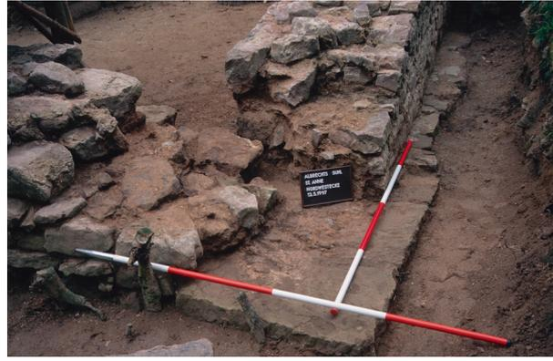
**Abb. 6** Suhl-Albrechts, Kapelle „St. Anne“, Schalenmauerwerk mit Verfüllung aus kleinen, in Kalkmörtel verlegten Sandsteinen
