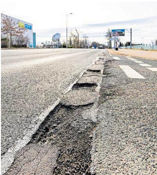
Eine Überalterung des Asphalts führt in der Gothaer Straße zu Schäden am Belag und zu Substanzverlust.
