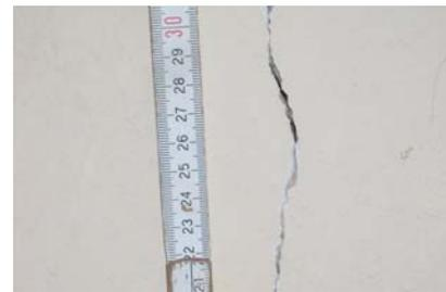
Abb. 23: Riss 1 in der unteren Hälfte der Wand 6
