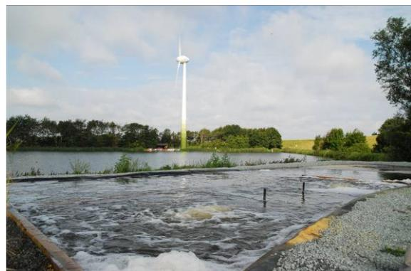
**Abbildung 4: Stufe 3, Belüftung, Absetzen und Filtration**
